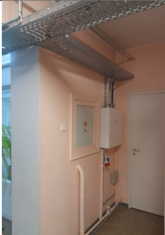
Paigaldati hoonesse vajalikud elektri jaotuskaablid.
