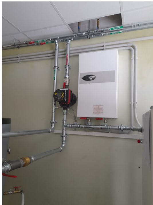
Elektrikatel, mida saab käivitada generaatori baasil.
