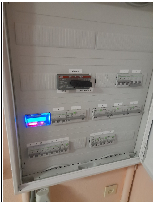
Peajaotuskeskusesse paigaldatud RLA, võrgutoite ümberlülitamiseks generaatori toitele.
